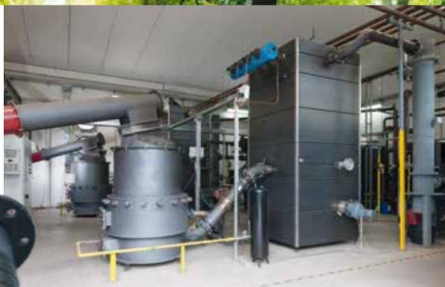
Das Prinzip „Energie aus Holz“ für kleine bis mittlere Kraft-Wärme-Kopplungsanlagen ist vom PACO-Kunden Holzenergie Wegscheid GmbH perfektioniert worden, seine Innovationen sind durch Patente geschützt. Die erfolgskritische Heißgasfiltration wurde in enger Zusammenarbeit mit der PACO F&E realisiert.
